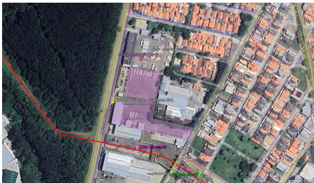
Figura 10 – Localização do Ponto de Conexão (-23.250647°, -45.919487°) da Instalação 0150598518.
