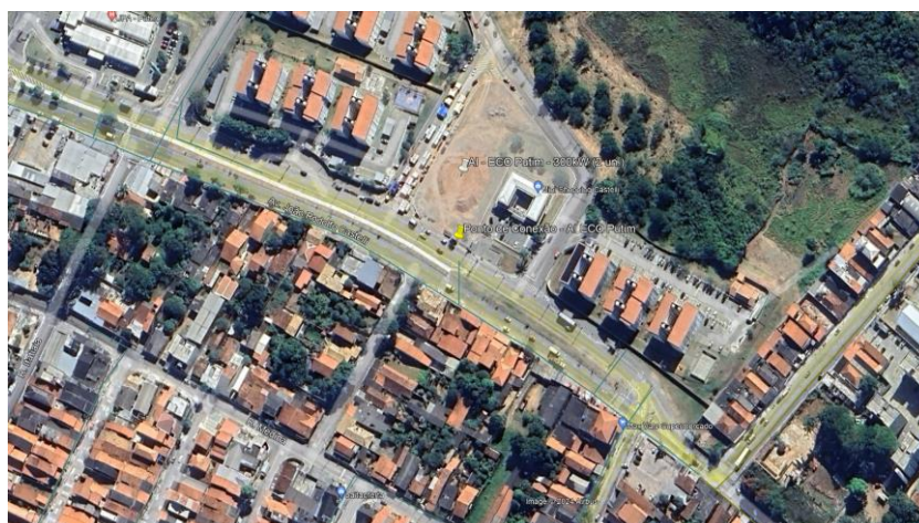
Figura 15 – Localização do Ponto de Conexão (-23.245818°, -45.830204°)
