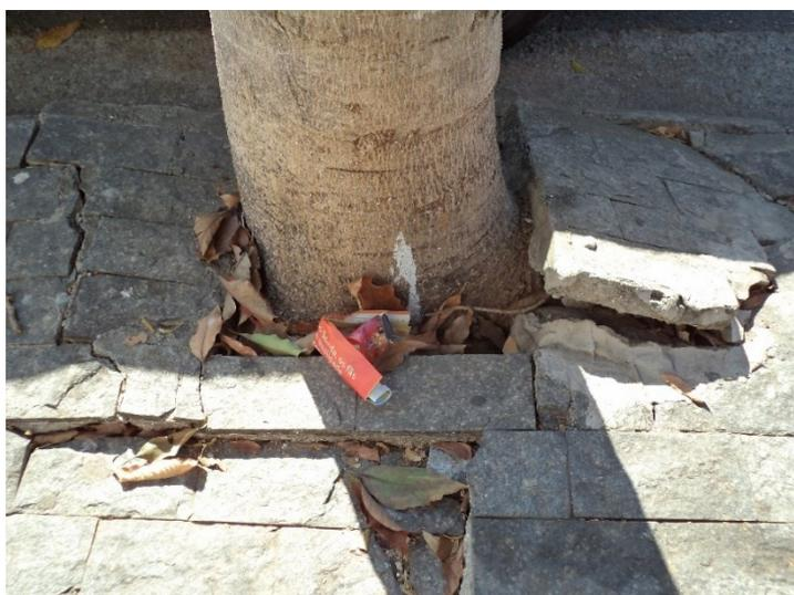
Figura 45 – Colo pavimentado e calçada danificada devido ao levantamento da raiz
