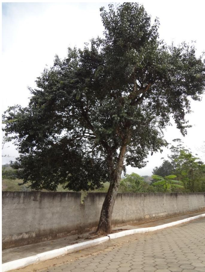
Figura 67 - Calçada pequena e levantamento de pavimento pela raiz da árvore Alfeneiro em SFX
