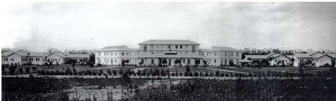
Pavilhões recém inaugurados vistos da parte traseira
