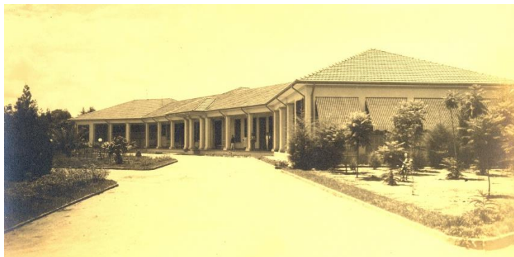
Pavilhão da Cia. Paulista de Estradas de Ferro recém inaugurado
