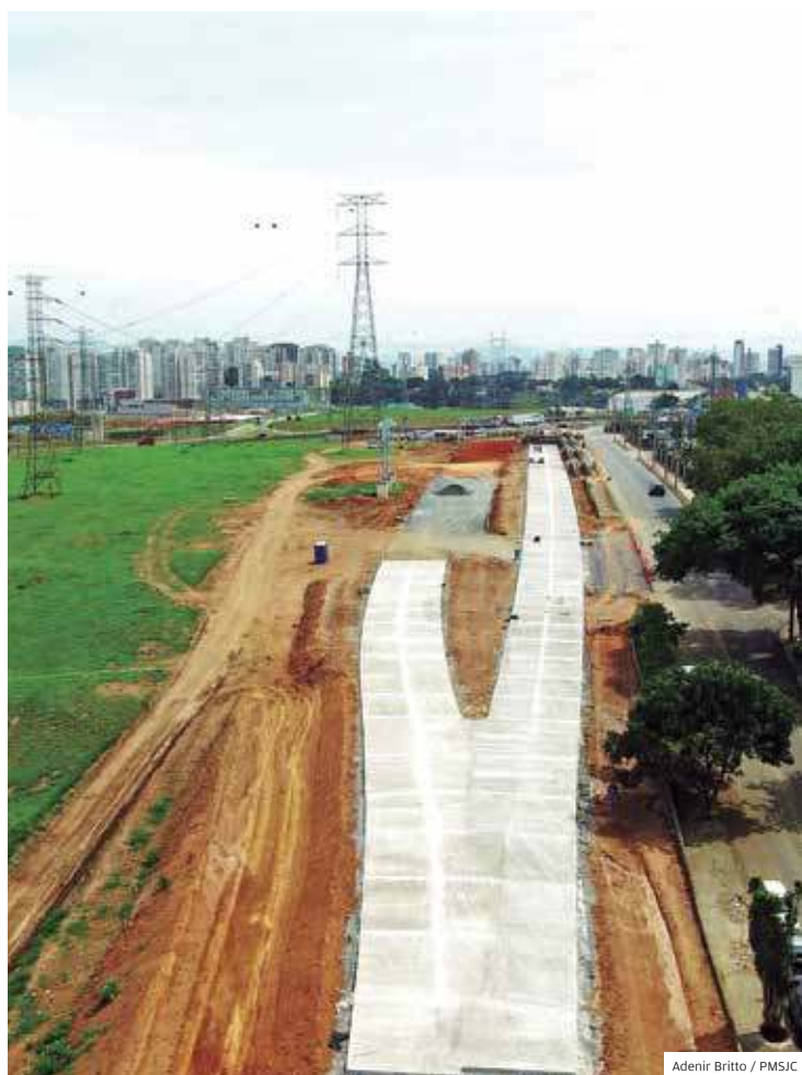
Avanço. Obras da Linha Verde estão em ritmo bem acelerado
