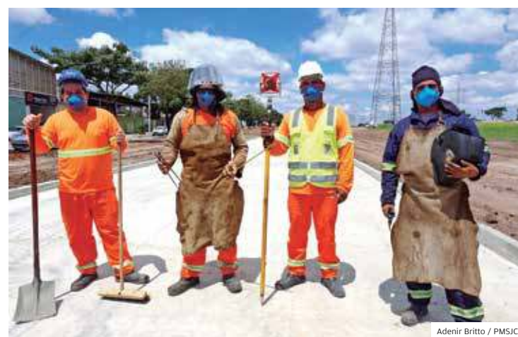
Mão de obra. Trabalhadores da Linha Verde no canteiro de obras
