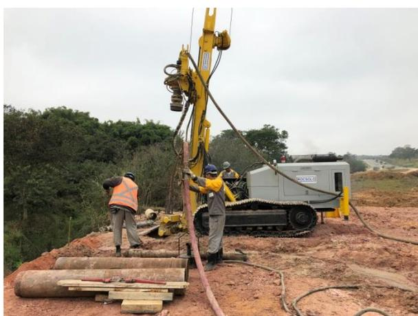
**Figura 12 - Equipamento para execução da fundação do Pontilhão 01 (fundação tipo estaca raiz).**
