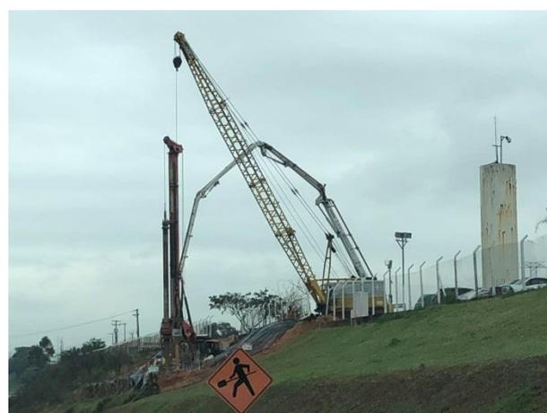
**Figura 17 - Concretagem da fundação (estação) da OAE03 - Apoio 02.**
