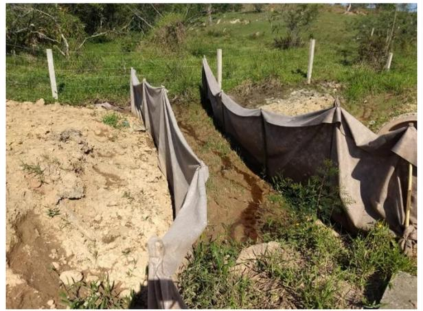
**Figura 52- Barreira de contenção feita de manta geotêxtil para impedir o carreamento de material para o córrego, km 0+500.**
