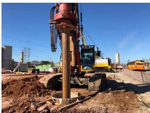
**Figura 16—Serviço de escavação para fundação da OAE 03 (fundação tipo estação) - Apoio 01.**
