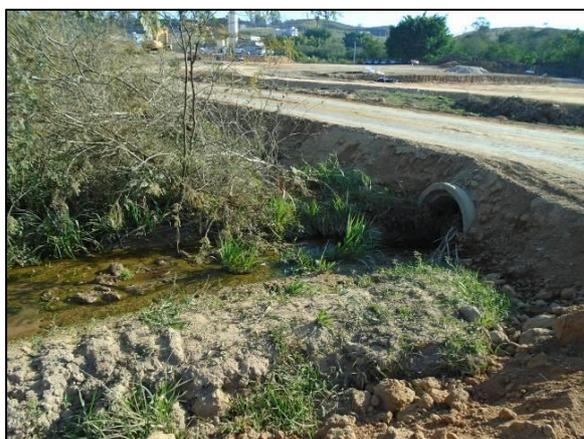
**Figura 39 - Dispositivo de drenagem provisório implantado no km 1+750.**
