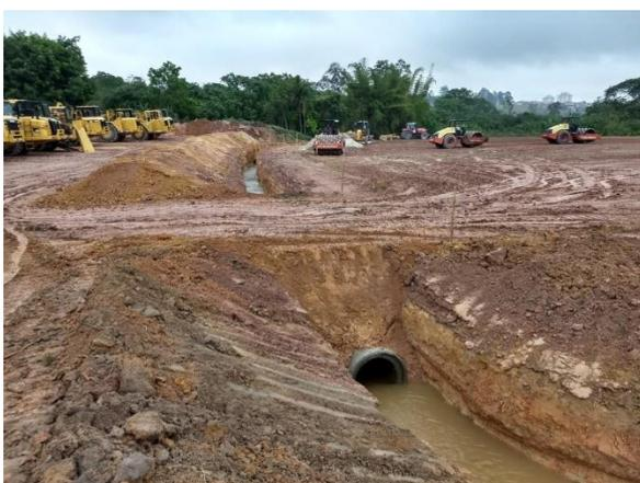
**Figura 37 - Dispositivo de drenagem provisório implantado no km 1+600.**
