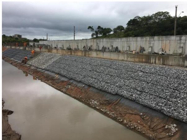
**Figura 51 - Execução de Colchão Reno para proteção de talude do Pontilhão 01, no Km 0+500.**
