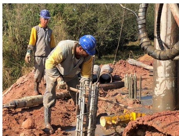
**Figura 13 - Equipamento para execução da fundação do Pontilhão 01 (fundação tipo estaca raiz).**
