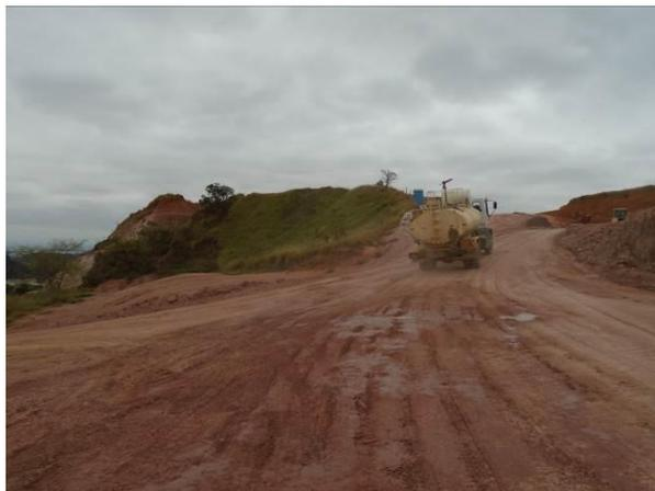
**Figura 43 - Umectação das vias internas da obra, reduzindo a quantidade de geração de material particulado (poeira).**
