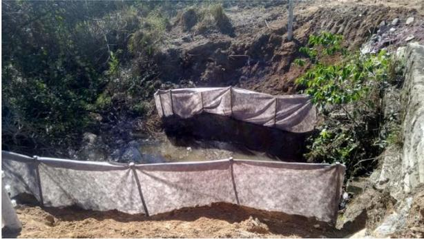
**Figura 49 - Barreira de contenção de manta geotêxtil para impedir o carreamento de material para o Córrego Cambuí, no km 0+860.**
