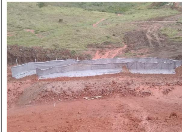
**Figura 40- Implantação de manta geotêxtil para contenção de carregamento de materiais provenientes de aterro, km 2+700.**
