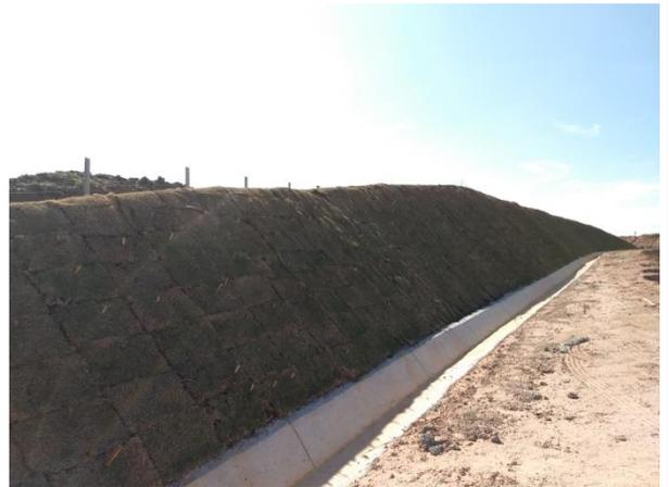
**Figura 50- Execução de grama em placa em talude de corte e canaletas de concreto para direcionamento de água pluvial.**
