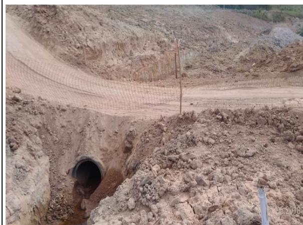
**Figura 38 - Dispositivo de drenagem provisório implantado no km 2+400.**
