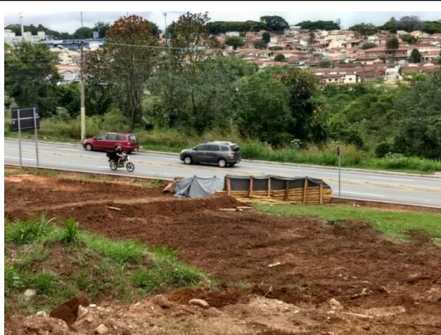
**Figura 43** - Paliçada para contenção de particulado na Rua Saigiro Nakamura.
