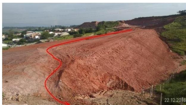
**Figura 54** - Direcionamento da água do centro do aterro para o terreno natural, com baixa declividade para diminuir o processo erosivo, km 2+700.
