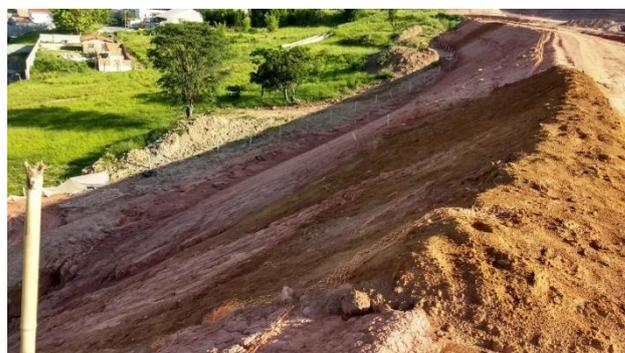
**Figura 52** - Reconformação de saia de aterro, com alteração do caimento, km 2+700.
