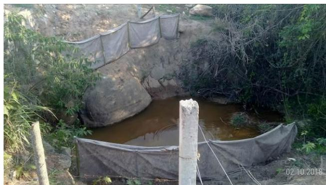
**Figura 59** - Contenção de bidim à jusante da travessia.
