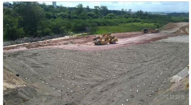
**Figura 36** - Tratamento de solo mole com uso de Moto scraper, km 3+850.
