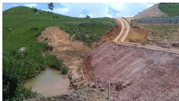
**Figura 50** - Recorformação da saia do aterro, km 2+500.
