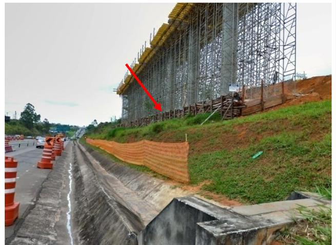
**Figura 75** - Barreira de contenção de madeira, Apoio 4.
