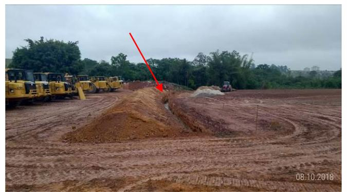
**Figura 61** - Dispositivo de drenagem provisório implantado, solo mole 4, km 1+750.
