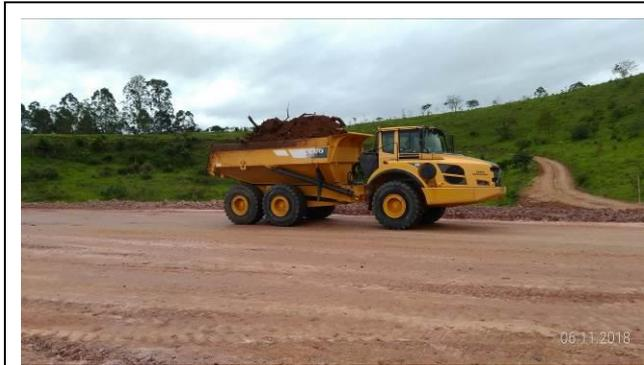
**Figura 35** - Transporte de material com caminhão fora de estrada, km 4+850.
