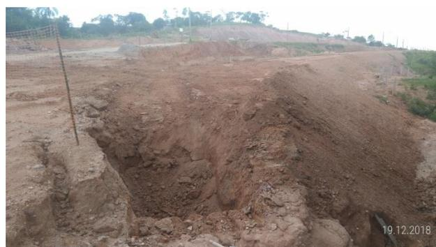
**Figura 48** - Direcionamento de águas pluviais e bacia de contenção de sedimentos escavada em terreno natural, km 1+300.
