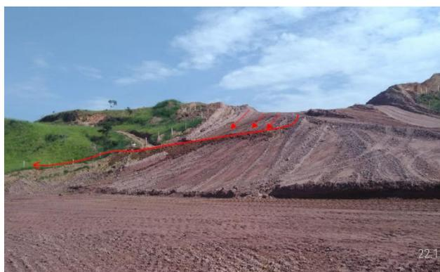
**Figura 49** - Implantação de curva de nível para controle de velocidade das águas pluviais e carregamento de particulado com saída para terreno com cobertura vegetal, km 2+500.
