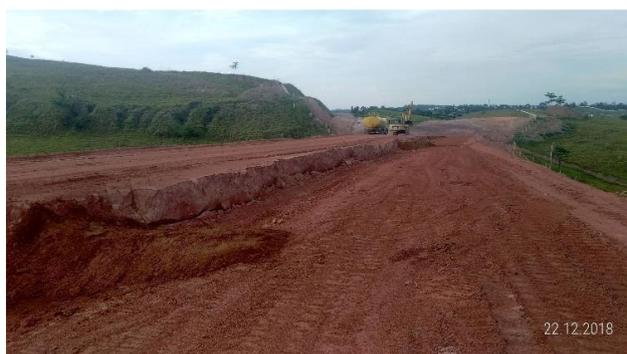
**Figura 53** - Reconformação das erosões no centro do aterro e implantação de leiras tipo espinha de peixe, km 2+700.
