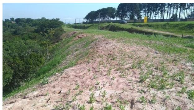
**Figura 46** - Aplicação de hidrossemeadura no bota-fora.
