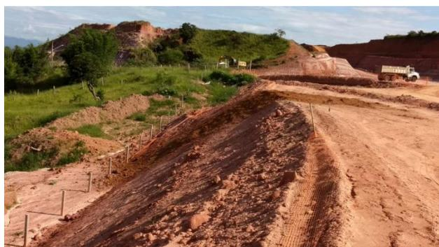
**Figura 51** - Reconformação de saia de aterro, com alteração do caimento, km 2+700.
