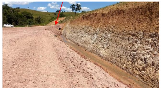
**Figura 65** - Detalhe da travessia em acesso e corta-rio implantado em lateral do tratamento de solo mole.
