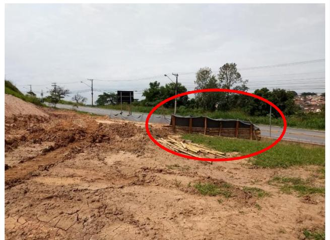
**Figura 77** - Barreira de contenção de sedimentos, trecho Rua Saigiro Nakamura.
