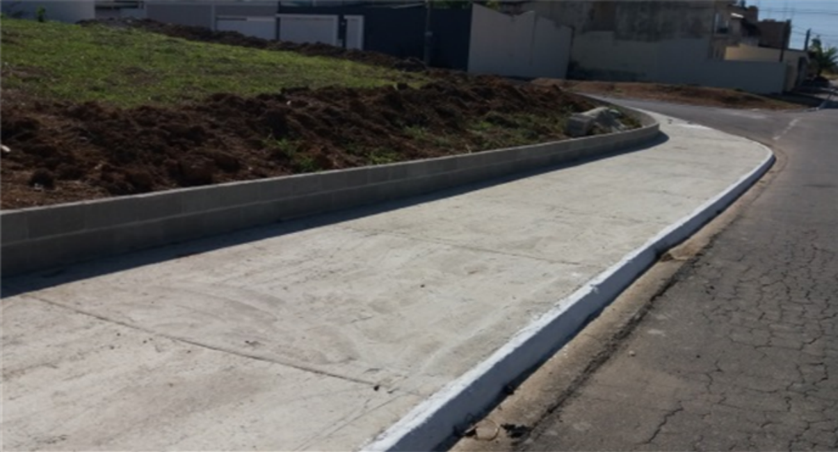
Calçada e mureta em terreno
