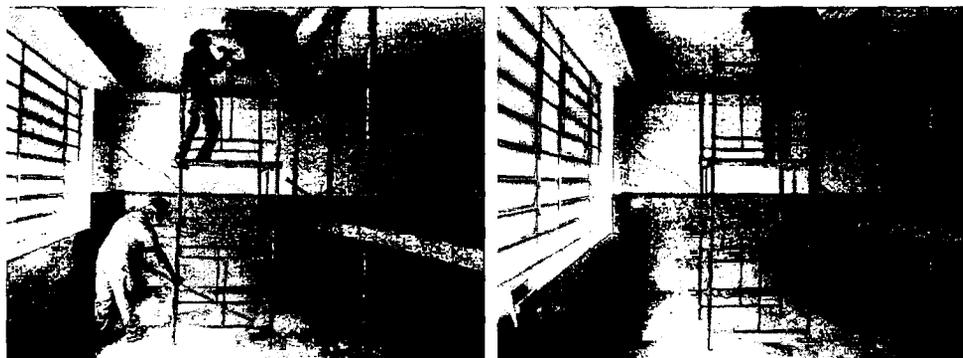
Demolição do forro de estuque de uma dos salões da edificação.
