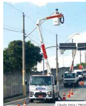
LED. Reparo na iluminação
