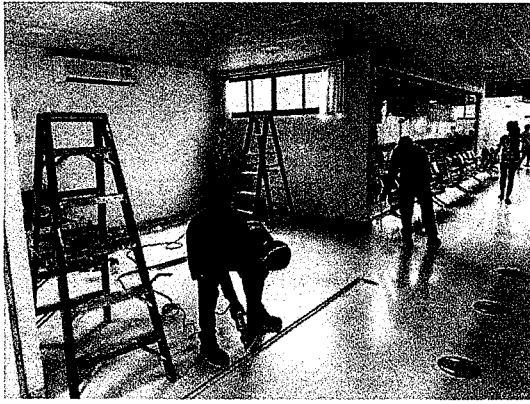
Aplicação de porcelanato em piso do corredor
