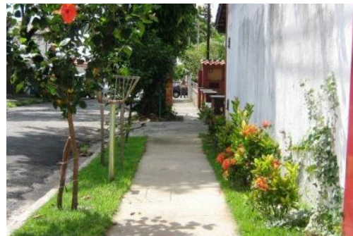
Pavimentação permeável na calçada (10 pontos)
