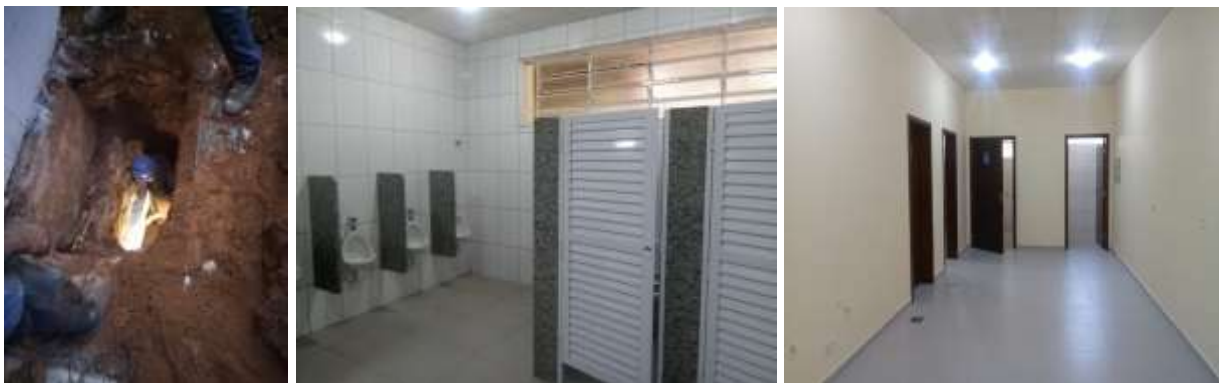
Demolições de alvenarias, execução de baldrame, reforço das fundações e restauro da área dos banheiros.
