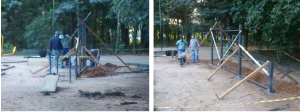
Execução das barras de alongamento da área interna do parque
