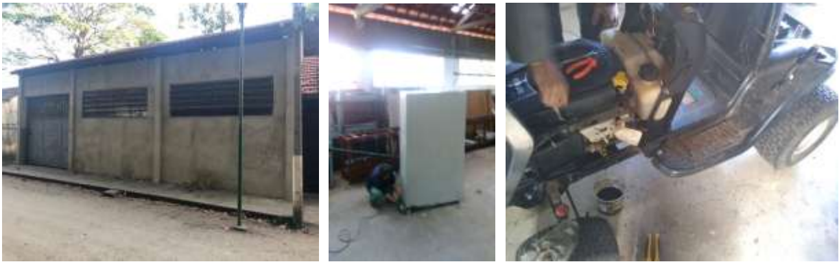
Galpão finalizado e em utilização.
