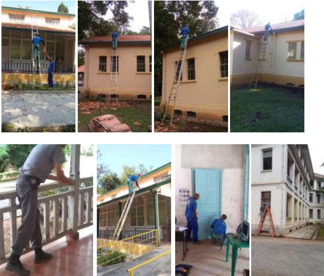
Serviços de conservação das edificações restauradas.
