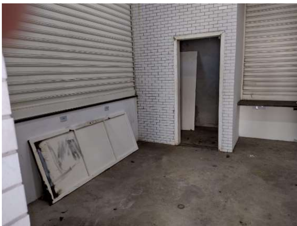
Foto 18: Área interna /Espaço reservado
