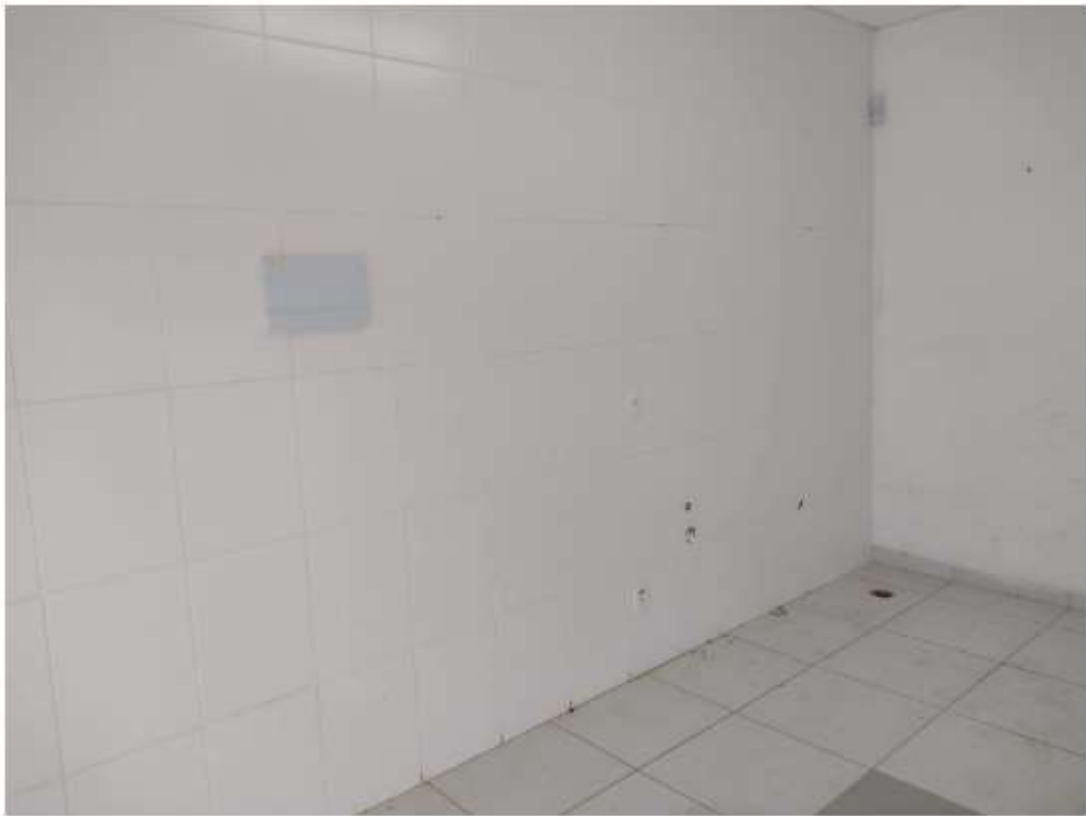
Foto 6 – Área interna do box
