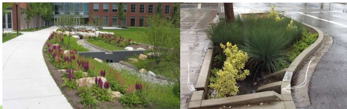
IMPLANTAÇÃO DE SISTEMA DE DRENAGEM URBANA SUSTENTÁVEL JARDINS DE CHUVA / VALA DE BIORRETIÇÃO
